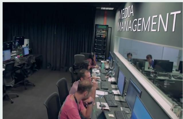
Den News-Bereich steuert ein komplett redundantes KVM-System, bestehend aus zwei Draco tera enterprise Matrixswitchen mit jeweils 160 Ports und redundanten Extendern auf Arbeitsplatz- und Serverseite. Das KVM-System verbindet die Anwender mit einer breiten Palette von Broadcast-Geräten und überträgt eine Mischung aus DVI, DisplayPort, seriellen Signalen, Audio und USB-Daten.
